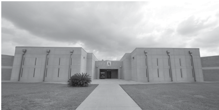
Fotografía 9: Nuevos dormitorios carcelarios en el PIDC, aprox. 2001-2017. Cuatro de esos dormitorios se completaron alrededor de 2004. Obsérvese las ventanas carcelarias de tamaño mínimo. Imagen de un video (US Immigration and Customs Enforcement, 2017).
