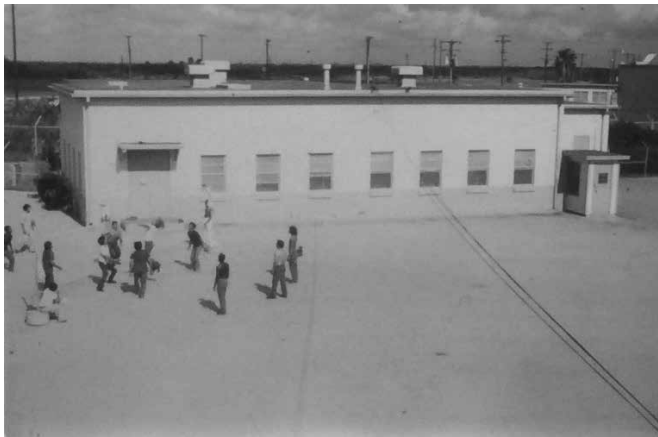
Fotografía 1. Instalación de detención original del PIDC, aprox. 1962. La instalación de detención adjunta a la Estación de la Patrulla Fronteriza abrió en 1961 originalmente para procesar «espaldas mojadas» en los últimos años del programa Bracero (que terminó en diciembre de 1964) (Fotografía 11.206a, ca. 1962, n.d.).
