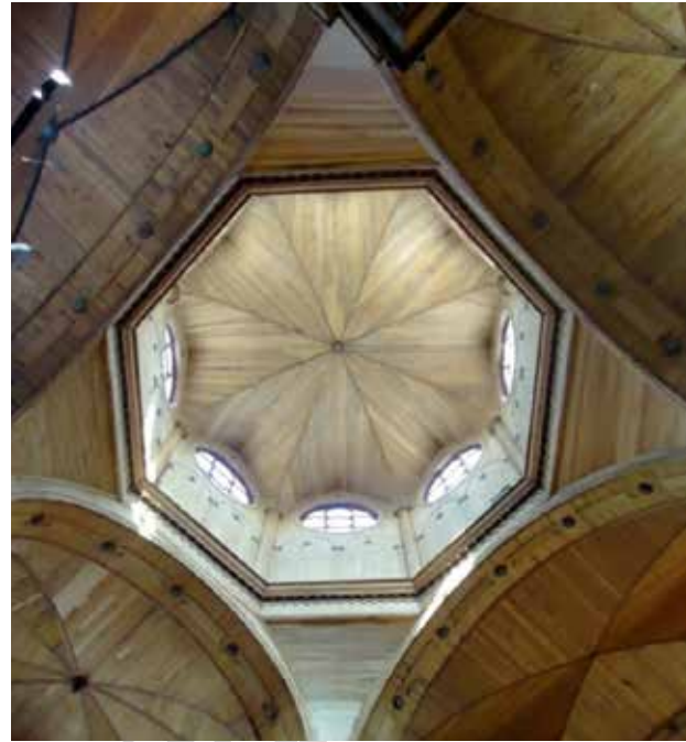
Figura 3. Cúpula octogonal de la Iglesia de San Francisco de Castro en Chiloé, Chile Fuente: fotografía de los autores.
