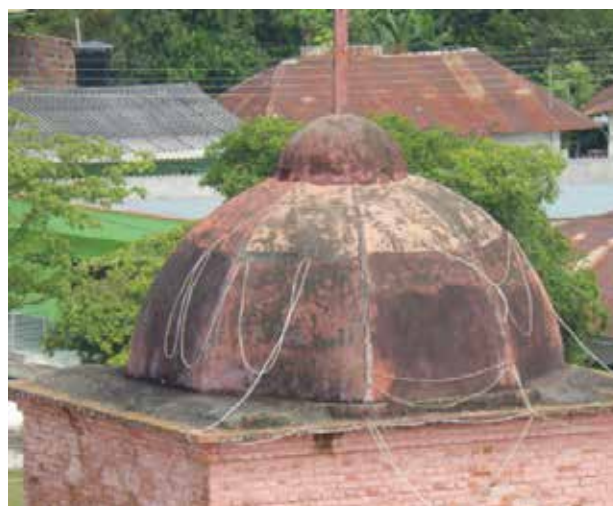
Figura 6. Vista exterior da cúpula do Templo Santa Lucía Fonte: fotografia dos autores.
