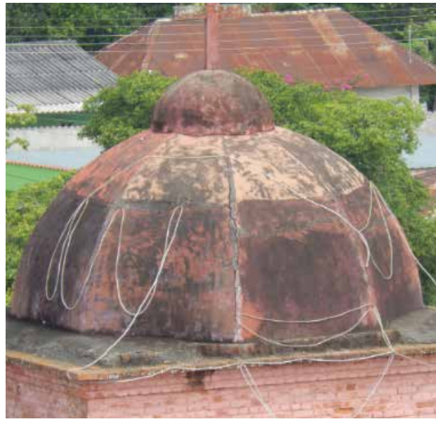
Figura 6. Vista exterior de la cúpula del Templo Santa Lucía Fuente: fotografía de los autores.
